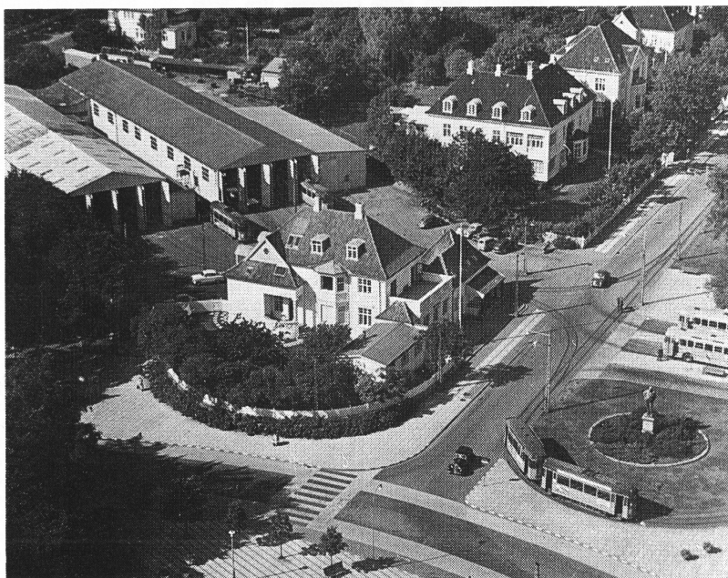
Remisen på Dalgas Avenue
